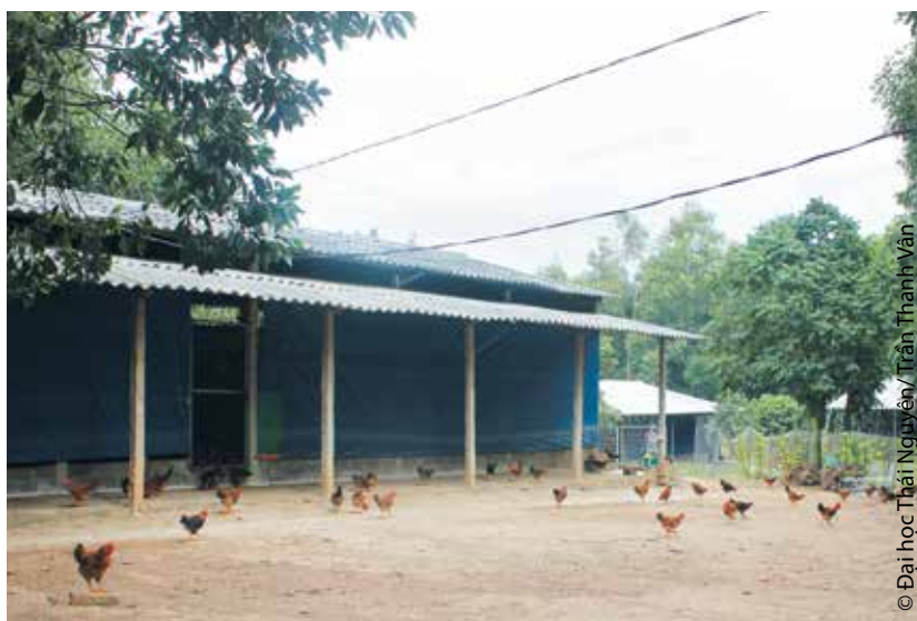
Hình 22. Mô hình chuồng gà 4 mái, thông thoáng tự nhiên
