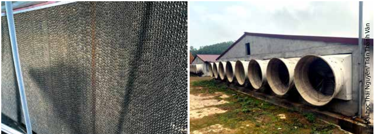
Hình 24. Tấm làm mát (trái), quạt hút (phải) lắp đặt ở chuồng kín nuôi gà
